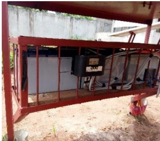
Figure 2 : Montage du kit solaire
