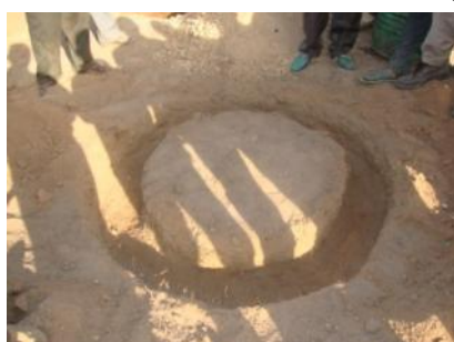
Fig. 6. Fouille de la fondation
