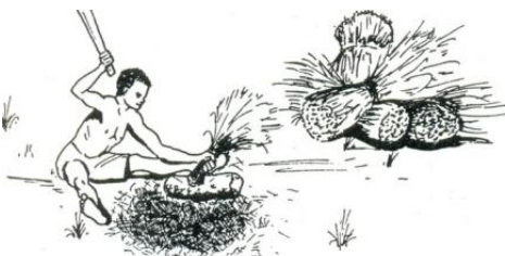
Fig. 10. Un constructeur hachant la paille
