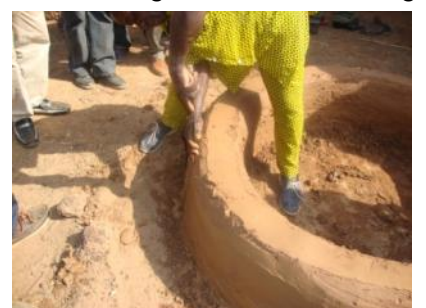
Fig. 8. Paroi du socle
