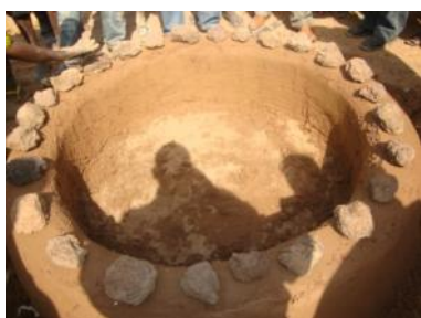
Fig. 9. Disposition des moellons
